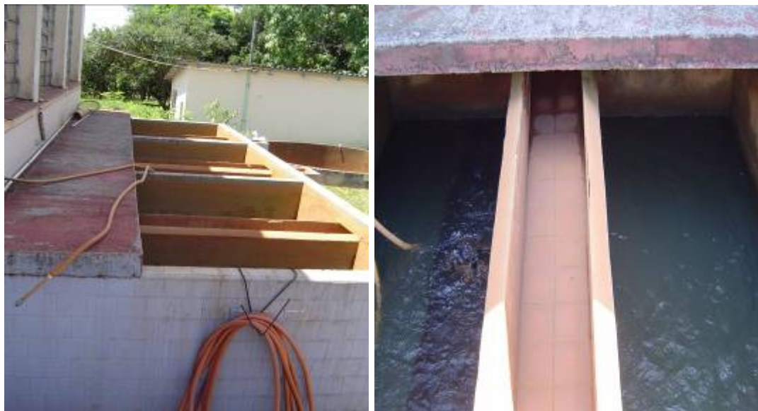
Figura 38 - Bateria de três filtros de leito misto areia mais antracito e calha de lavação.
