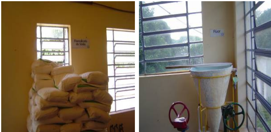
Figura 51 – Estocagem e cone dosador de fluossilicato de sódio.
