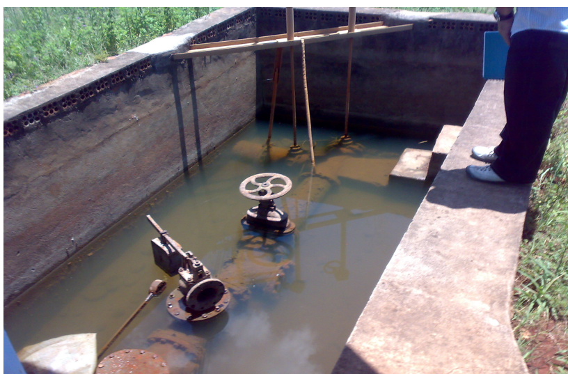
Figura 32 - Barrilete de recalque da adutora de água bruta
