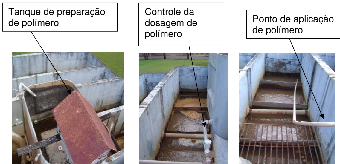
Figura 34 – Floculador tanque de preparação de polímero e ponto de aplicação
