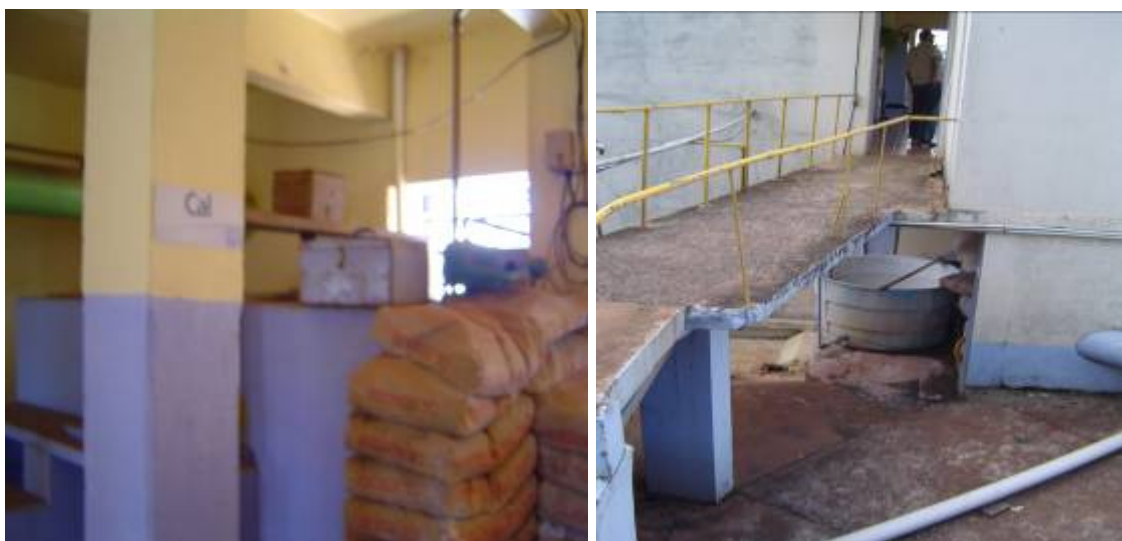
Figura 49 – Estocagem de cal hidratada e reservatório de preparação de solução
