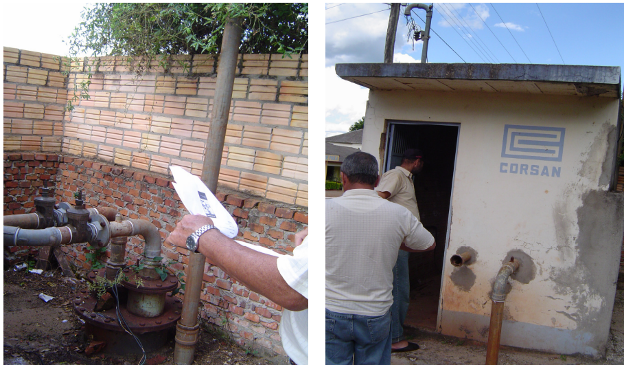
Figura 60 - CMB e abrigo do quadro de comando da elevatória.
