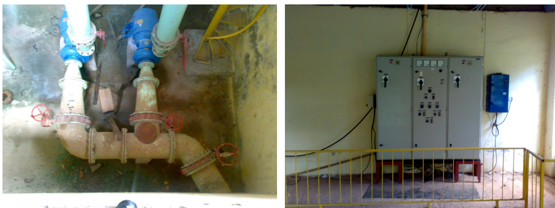
Figura 58 - Quadro de comando dos CMB da elevatória da Eta
