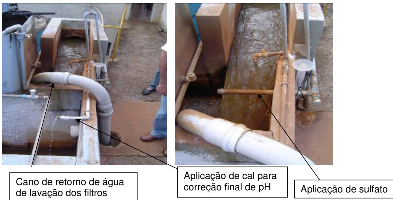
Figura 33 – Entrada de água bruta aplicação de sulfato de alumínio cal e cano de reaproveitamento de água de lavagem dos filtros.
