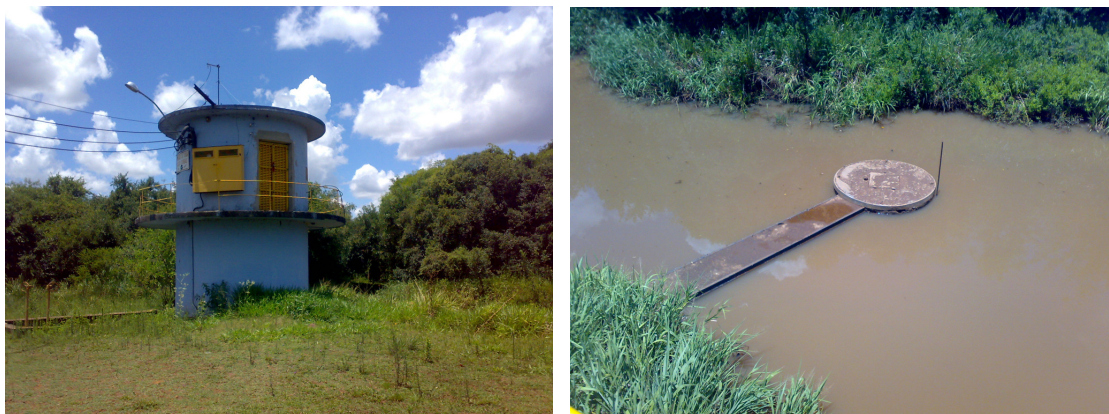
Figura 31 - Tubulão de concreto, canal da tubulação e casa dos conjuntos moto bomba.
