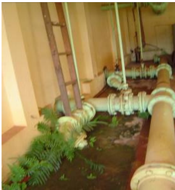
Figura 40 - Conjunto de acionadores manuais e válvulas dos filtros.
