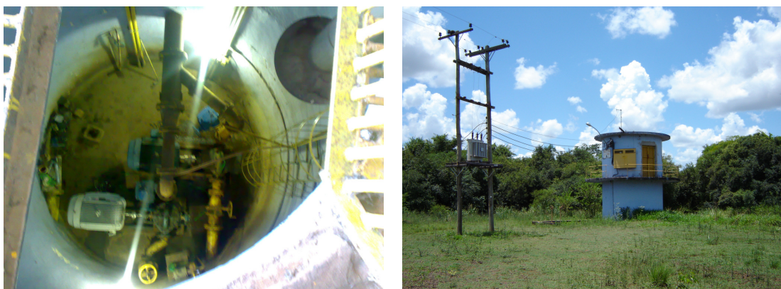
Figura 57- Vista interna e externa do tubulão que abriga os conjuntos moto bomba e do transformador de tensão.
