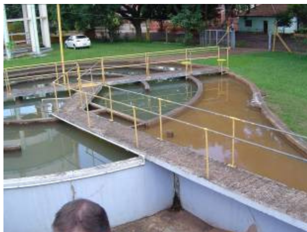
Figura 35 – Saída do floculador
