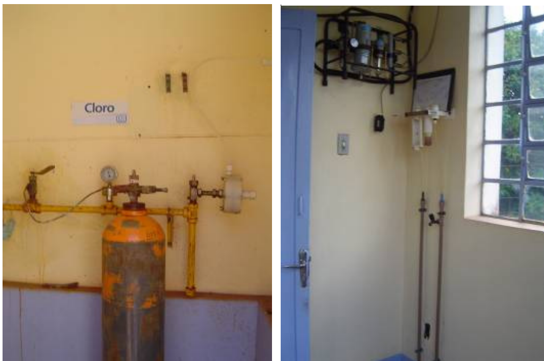
Figura 43 – Cilindro válvula reguladora de pressão e rotômetro para gás cloro.
