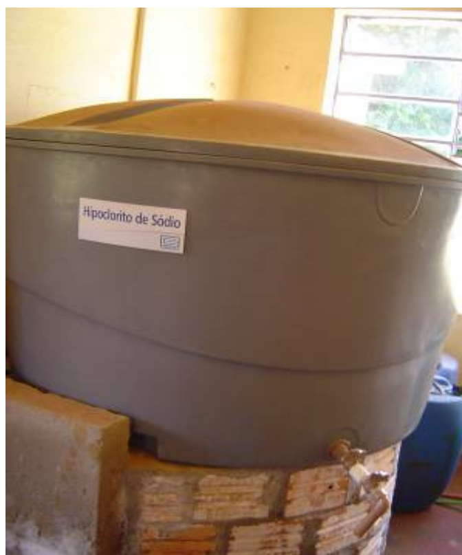
Figura 52 – Armazenamento de hipoclorito de sódio.
