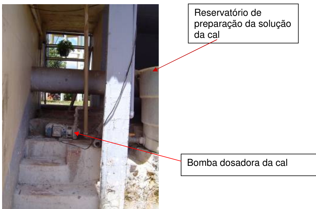
Figura 45 – Demonstrativo do controle da dosagem de cal.
