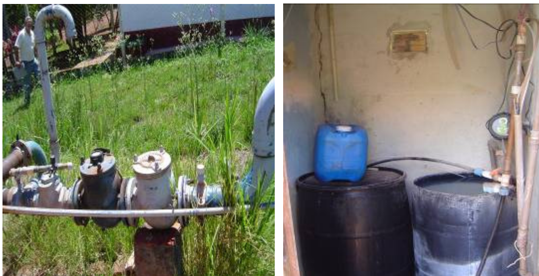
Figura 55 – Poços 3 COHAB e casa de química para preparação e dosagem.
