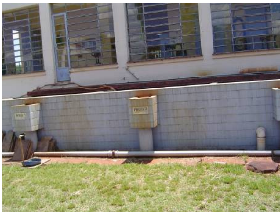
Figura 39 – Coletores de água de lavação dos filtros.
