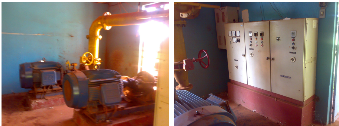
Figura 61 - Quadro de comando dos CMB da elevatória do 3º recalque dos poços profundos
