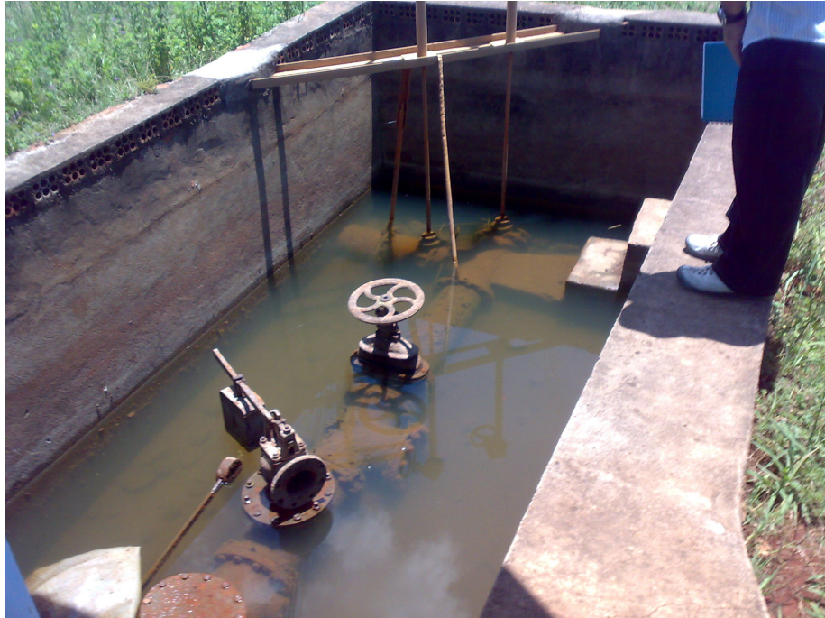
Figura 76 – Barrilete de recalque de onde sai as duas adutoras de água bruta
