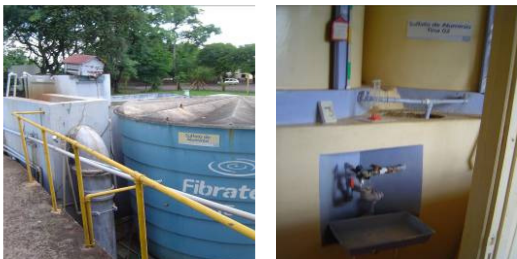
Figura 50 - Reservatório e dosadora gotejante de sulfato de alumínio.
