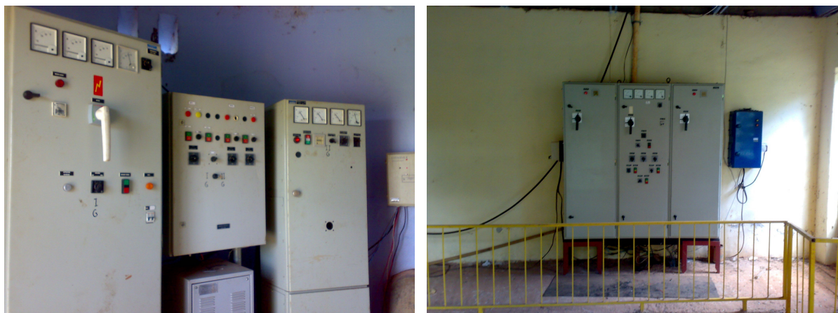
Figura 77 – Quadros de comando dos CMB da captação e da ETA.
