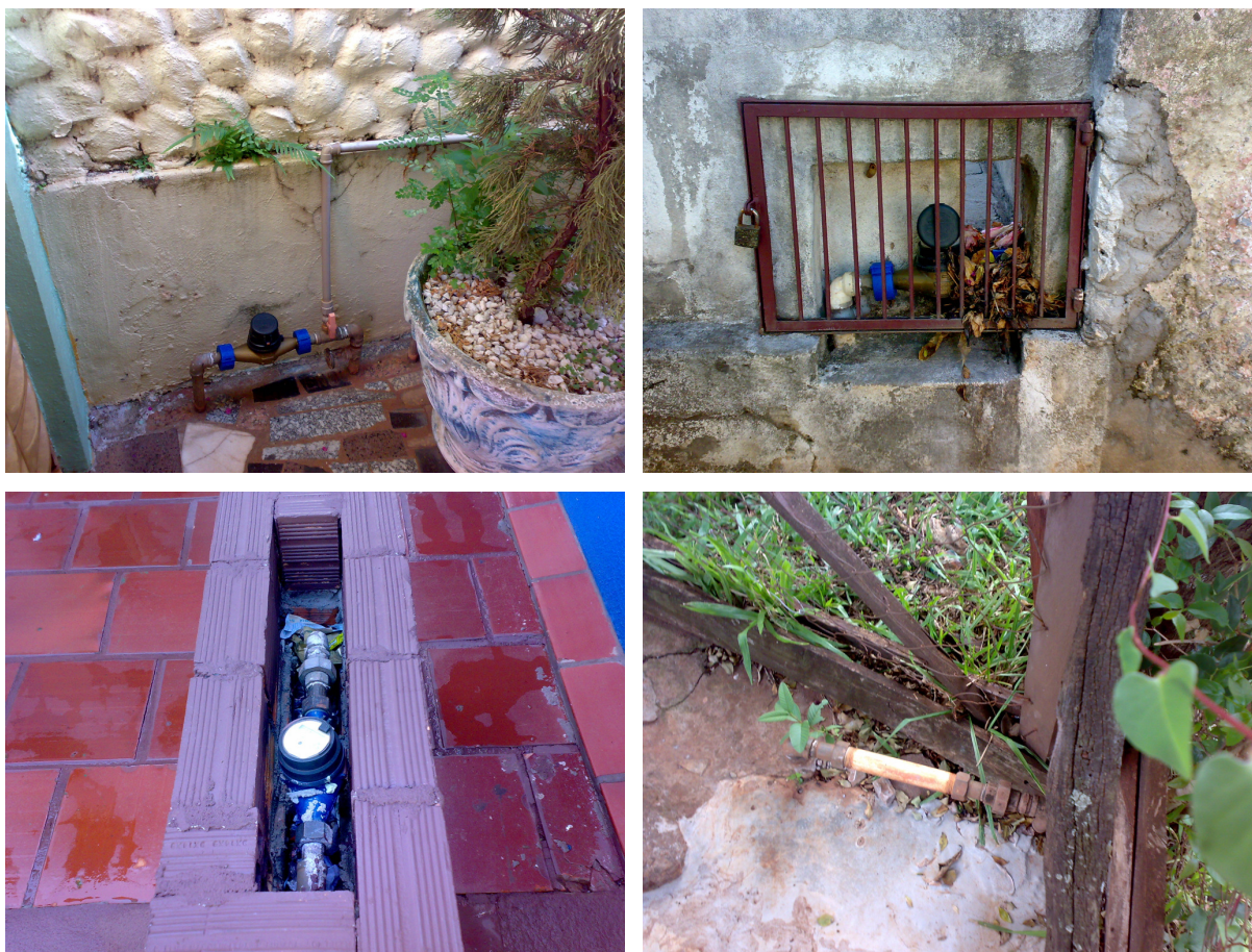
Figura 82 – Amostra de vários tipos de instalação de hidrômetros.
