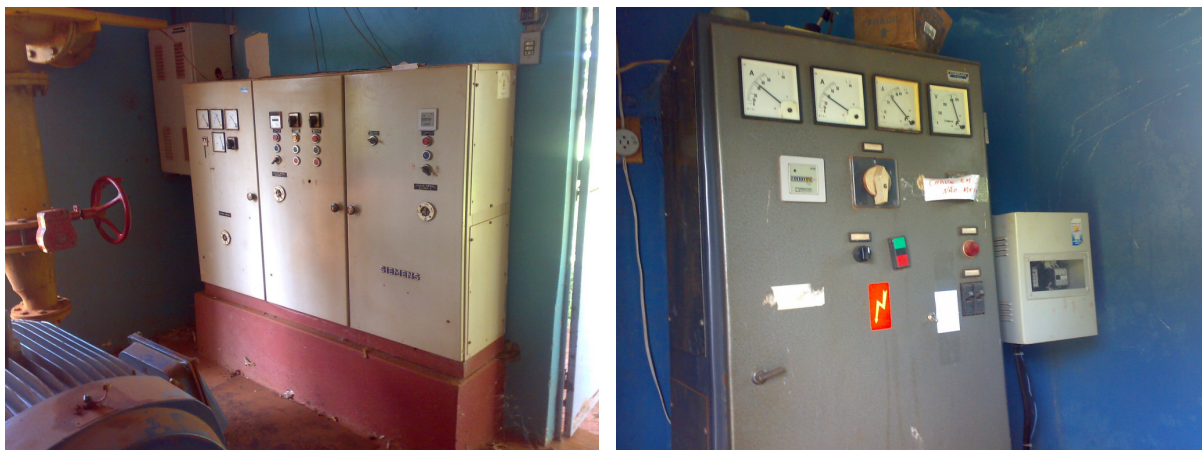
Figura 78 – Quadros de comando do 3º recalque dos poços e do poço 3 - Cohab.
