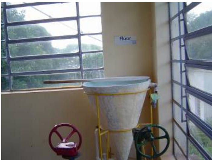
Figura 42 - Cone para dosagem de fluossilicato de sódio.
