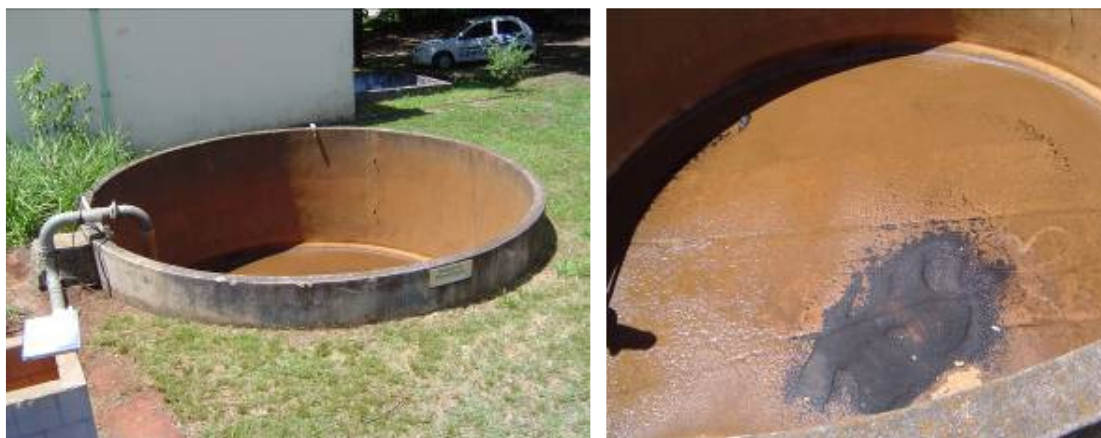
Figura 41 – Reservatório de recirculação de água de lavação dos filtros.
