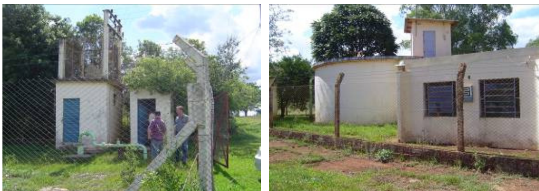
Figura 54 – Poço número 5 casa de química e de bombas com reservatório apoiado de reunião dos poços e tratamento com cloro e flúor.
