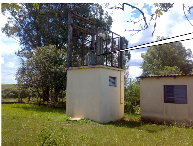
Figura 62 – Transformador de tensão do 3º recalque
